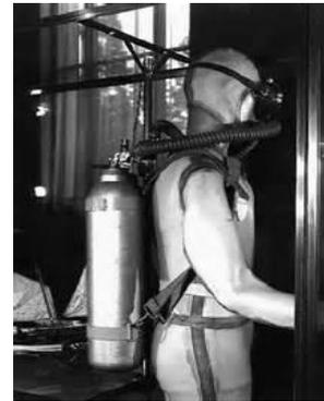
Il améliore en **1946**, le vêtement dit à « volume constant » destiné aux eaux très froides. Le plongeur le gonfle d'air en soufflant directement dans son masque et obtient non seulement un système de stabilisation mais aussi un isolement thermique efficace.
